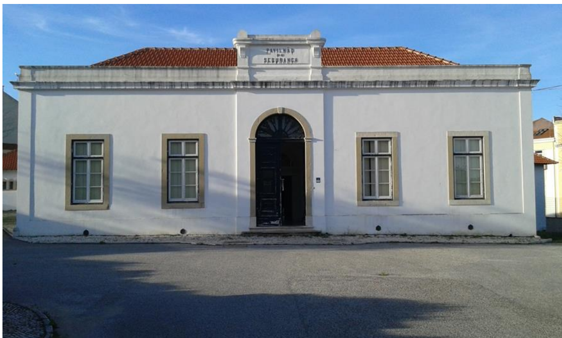
Figura 8: Enfermaria 8 do Hospital Miguel Bombarda. Por cima da porta pode lêr-se Edifício de Segurança, onde Ângelo de Lima esteve internado entre 1902 e 1921. (imagem captada no Hospital Miguel Bombarda em 2015)
