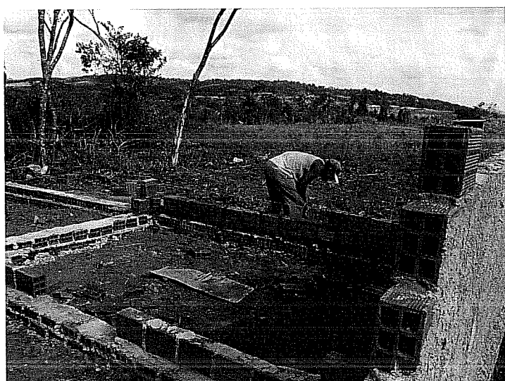
A Construção das casas no Assentamento Maré (Mata Norte)
