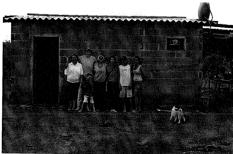
Casa de alvenaria com telhado em amianto, construída com o financiamento habitação. Abastecimento de água improvisado e cozinha ao fundo da casa, com fogão a lenha.
